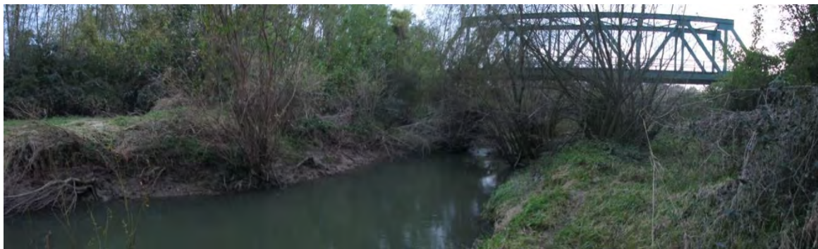
Slika 5.2.1- 2 Lokacija prijelaza trase magistralnog plinovoda Slatina-Velimirovac preko vodotoka Vojlovice. Prijelaz trase preko vodotoka nalazi se na udaljenosti od cca 20 m nizvodno od željezničkog mosta
