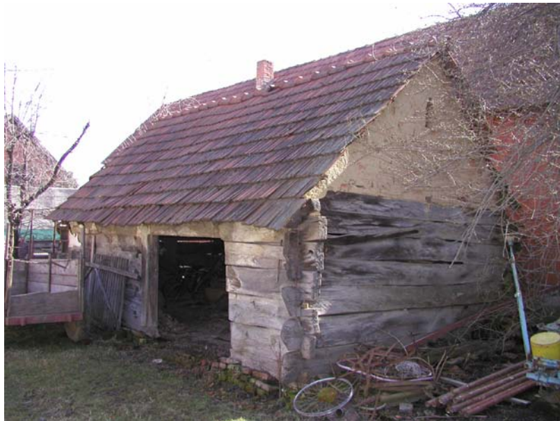
Slika 14. Kozice - tradicijska gospodarska zgrada podignuta kao brvnara
