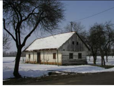
46. Sladojevački Lug, tradicijska kuća brvnara
