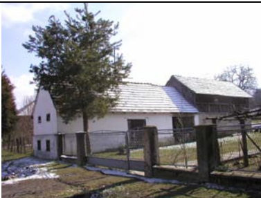
7. Bistrica 15 – velika gospodarska zgrada sa stajom i čardakom
